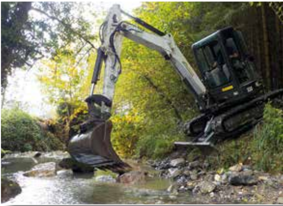
Travaux sur l'Hers vif, à Fougax-et-Barrineuf
