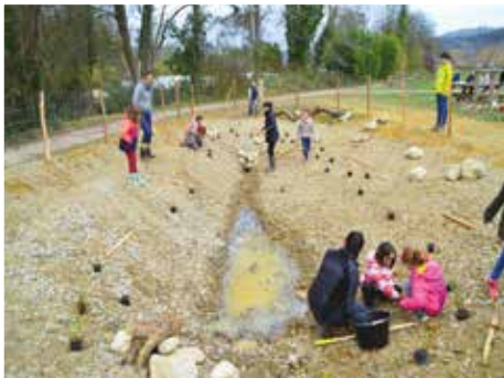
La mise en terre des plants
