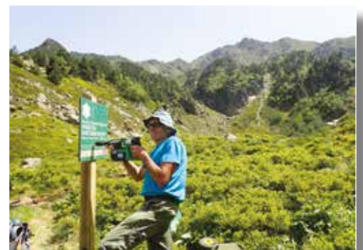
Pose de panneau le long du sentier
